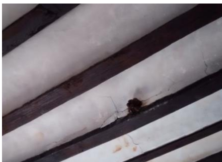
Une charpente de toit avec des chauves-souris en été (Photo : Scruzcampillo)
