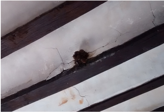
Ein Dachstuhl mit Fledermäusen im Sommer
