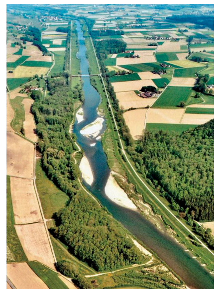
Abbildungen 1 und 2: Thur Schöffäuli vor (oben) und nach der Revitalisierung (unten). © C. Herrmann / BHAtteam Frauenfeld
